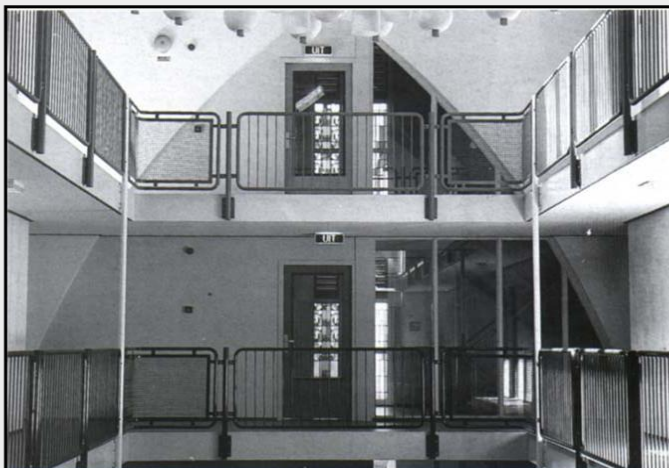
De nieuwe ingang aan het Kwerenpad voert langs lift en trappenhuis naar een atrium in het midden van de kerk. De galerijen lopen rondom, waardoor het probleem van de vluchtwegen werd opgelost.
