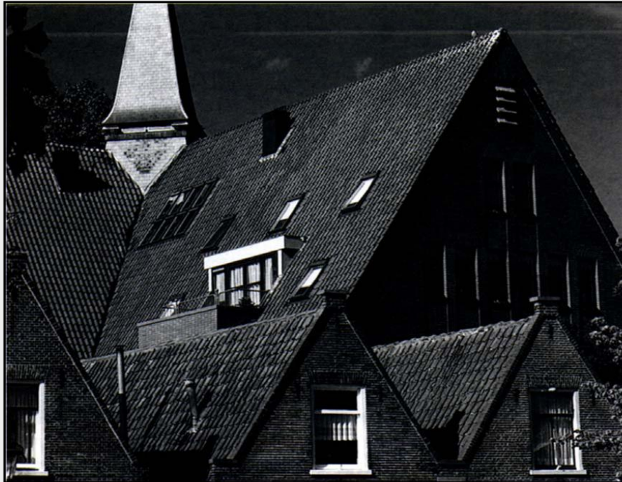
In het zijdakvlak zijn als buitenruimte voor de woningen enkele balkons aangebracht in een stijl die aansluit bij het beeld van de kerk. Alleen de woningen in de kap hebben op enkele plaatsen oude spanten in het zicht.
