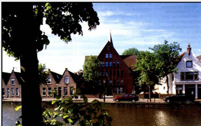
De belangrijke bijdrage van de Verlosserskerk aan het stadsbeeld was een reden het gebouw te verbouwen tot 19 driekamerwoningen voor ouderen.
